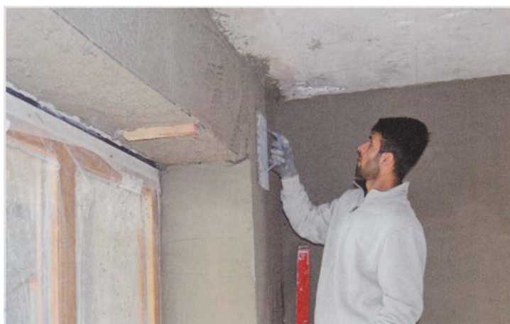
2 Hawkar Mahmod überzeugt auf der Baustelle mit seinen handwerklichen Fähigkeiten.
