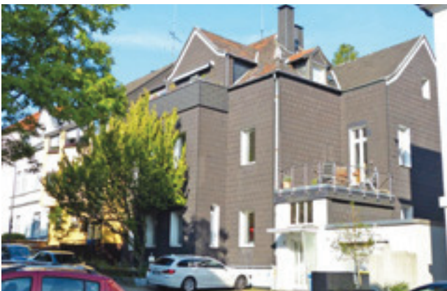
3 Eine Bausünde aus dem Jahr 1980: Die Villa wurde mit einer Bekleidung aus dunklen Fassadenplatten versehen.
