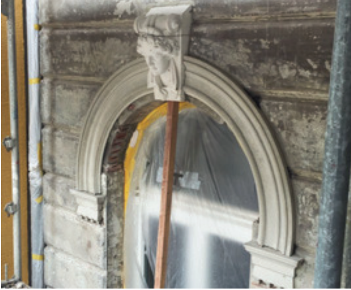
9 Von der alten Stuckverzierung war an vielen Stellen nicht mehr viel übrig.
