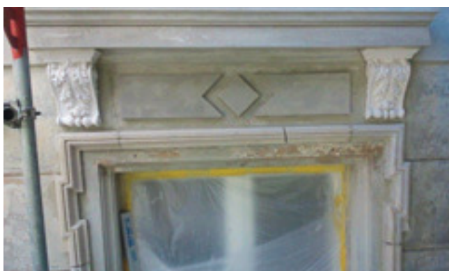
7 Details an den Fenstern wurden fachgerecht nach alten Vorgaben ausgearbeitet.
