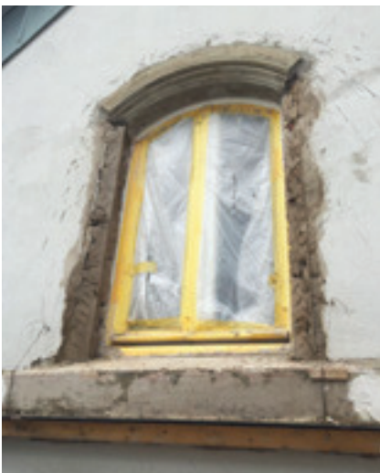
11 Details wie dieser Segmentbogen über den Fenstern wurden vor Ort gezogen.
