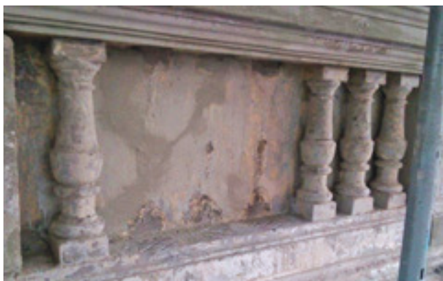
5 Die noch vorhandenen Baluster waren eine wichtige Orientierungshilfe zur neuen Anfertigung.
