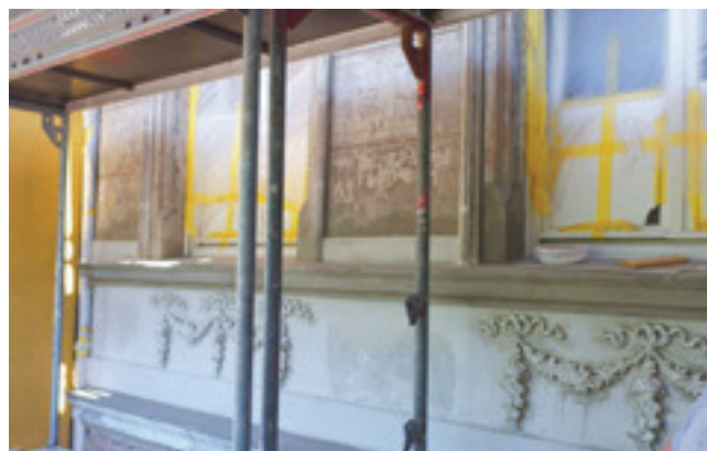
6 Langsam entstand die neue »alte« Fassade.
